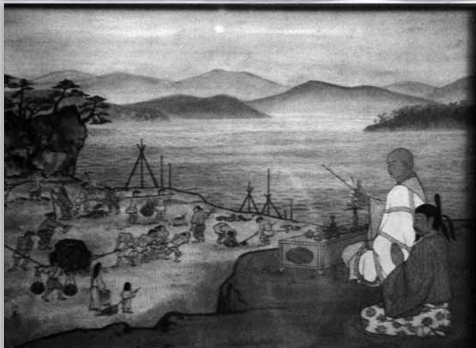
弘仁十二年(821)48歳 讃岐国の灌漑用溜池、満濃池の改修工事を指導監督、難工事を三ヶ月で完成させた。《覚鳳寺収蔵》
